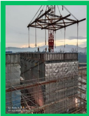
Gambar Foto Sebelum & Sesudah Pelaksanaan Konversi alat penangkap debu Electrostatic Precipitator (EP) menjadi Bag Filter
